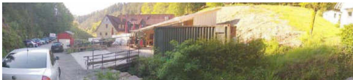
Abbildung 5: Westliche Teilfläche des Geltungsbereiches mit dem Gebäude des Gasthofes und neu errichtetem Anbau (Quelle: Büro Gfrörer).
